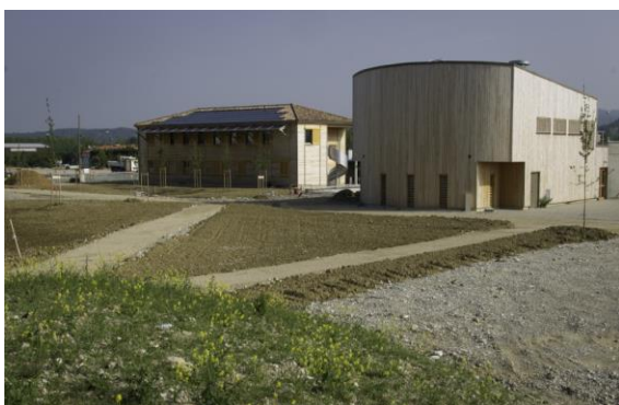
Salle de conférence et pépinière d'entreprise sur l'écosite d'Eurre
